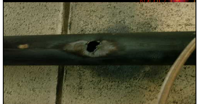
圖2：爆炸波貫穿分裝鋼管（鋼管內遺留熔融鐵塊）
